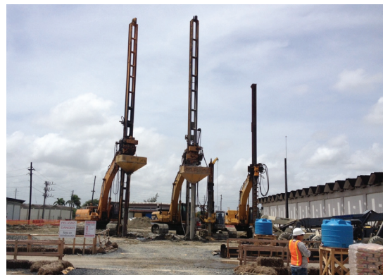
Instalación del sistema Impact
