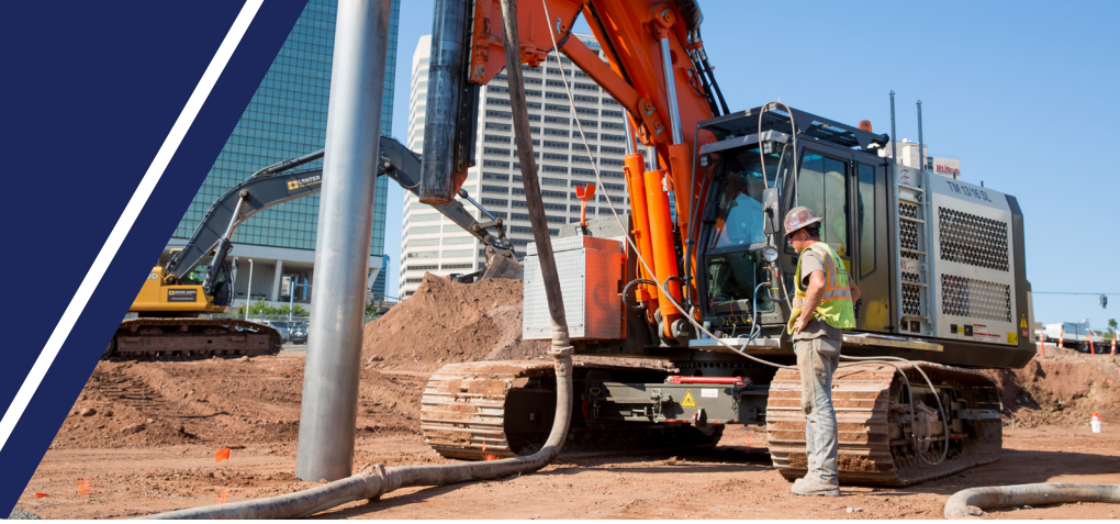
Geopier GeoConcrete® Columns (GCC)
